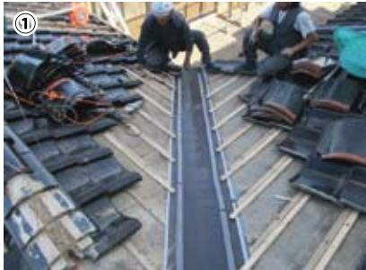
谷トタンを交換して、瓦桟木を新調します。トタンに、逆水止めのシールを張ります。
